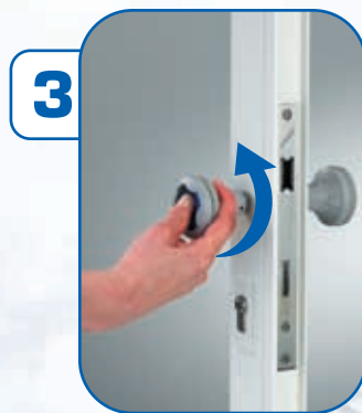
En synchronisant ces deux actions, tourner la poignée pour rétracter le 1/2 tour de la serrure
